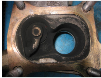
Junta montada incorrectamente
