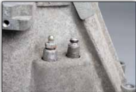
Slika 3: Demontaža stare izvedbe
