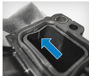
Fig. 2: Quebra (imagem do dano)
